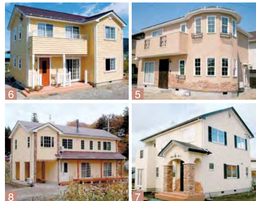
5.6.7.8.ブルースホームの施工実例。数多くの施工実績がある
